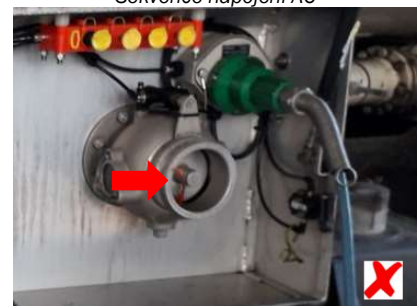
Nepovolené zajištění ventilu
