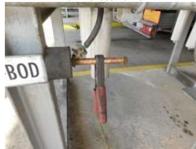
zemní bod technologie VL
