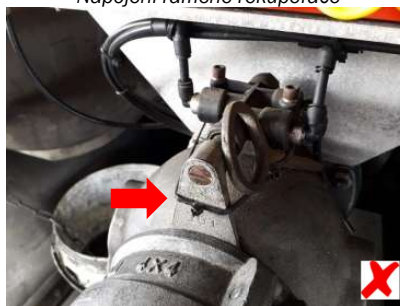
Nepovolené zajištění ventilu
