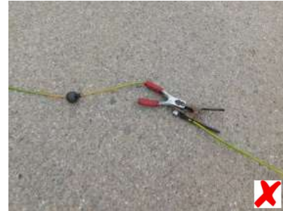
Pospojení „kabel-kabel“
