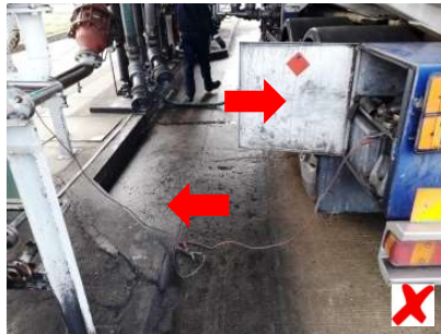
Nesprávné provedení zemnění
