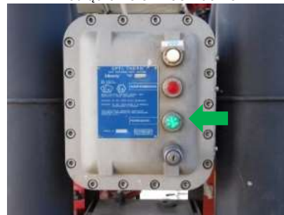
CIVACON podłączony
