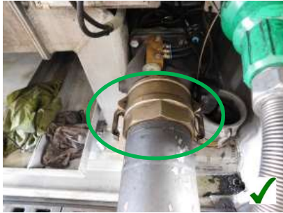
Zabezpieczenie ramienia rekuperacyjnego
