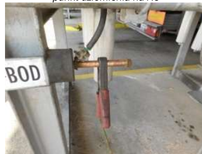
punkt uziemienia technologii urządzenia wydającego (UW)
