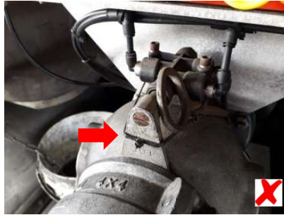
Niedozwolone zabezpieczenie zaworu
