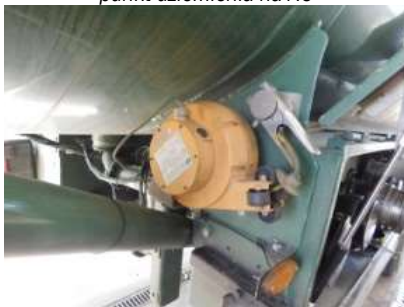
bęben uziemiający AC
