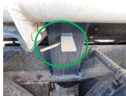
Точка заземлення на АС
