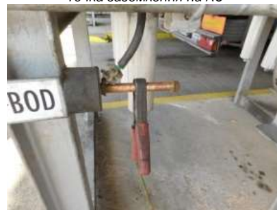
Точка заземлення технології VL
