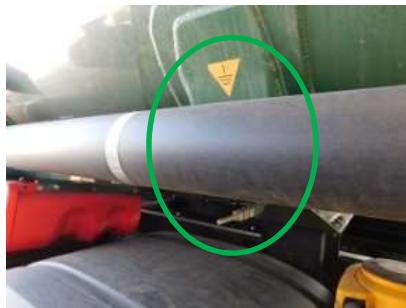
Точка заземлення на АС
