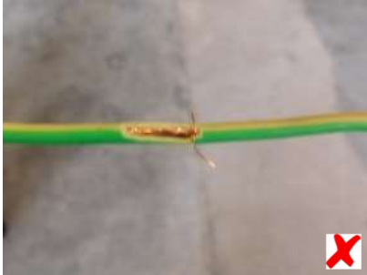
Пошкоджений кабель заземлення
